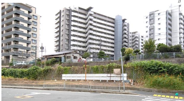
ハセンドウ坂跡 ガードレールがもとの踏切箇所
