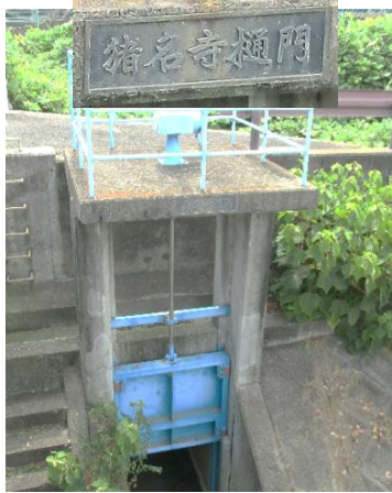
猪名寺樋門と銘板
